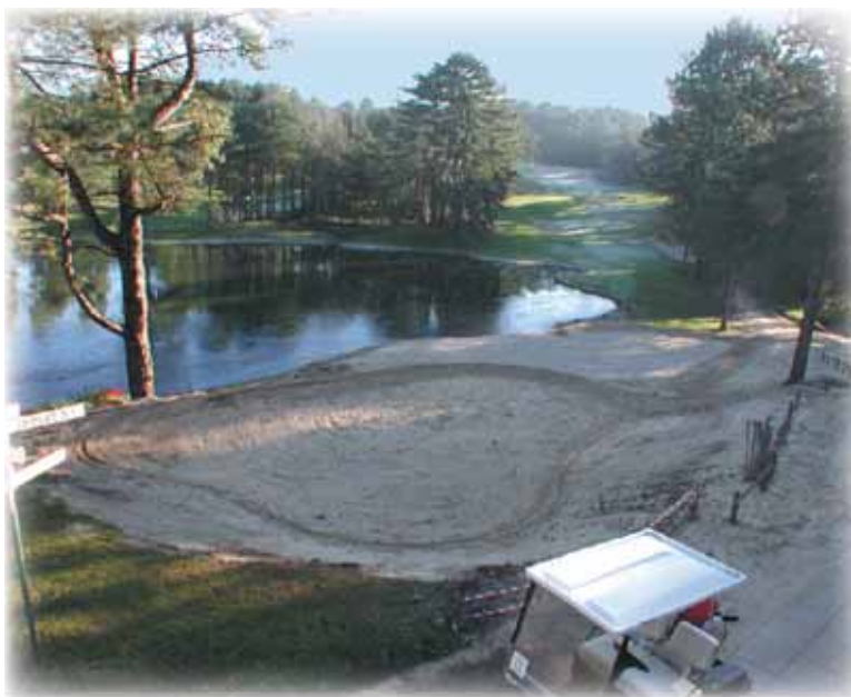
Pendant les travaux
